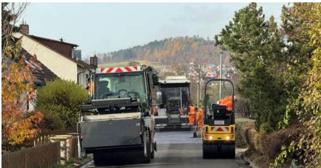
Straßenunterhalt Mühlwiesenweg und Mühlleite
