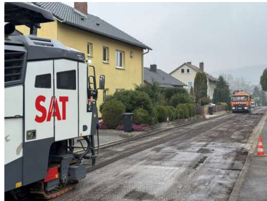
Straßenunterhalt Steinernes Stück
